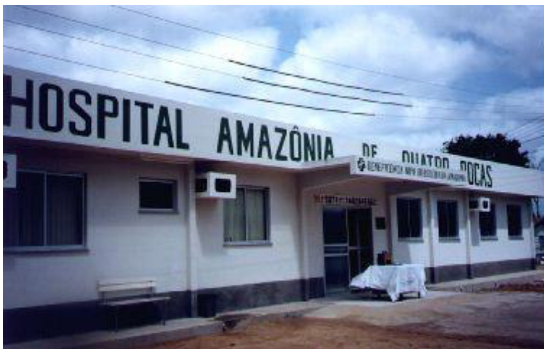
Fachada do Hospital Amazônia de Quatro-Bocas
