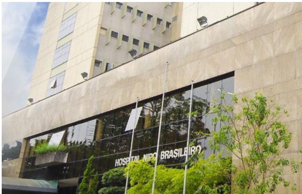
Fachada do Hospital Nipo-Brasileiro-São Paulo (SP)
